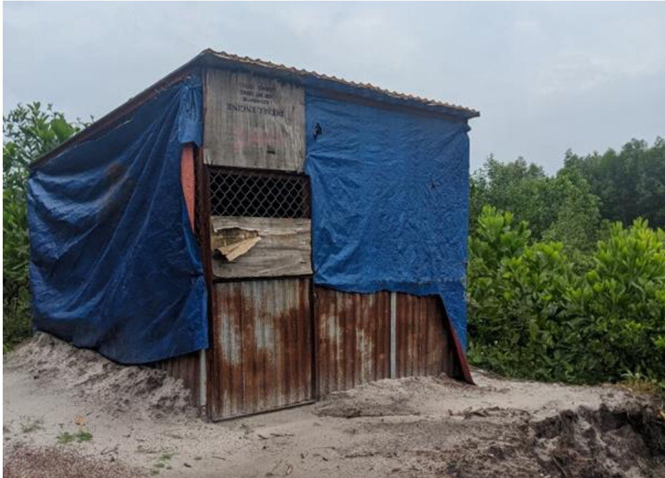
Hình 1.6 Lán trại canh gác trên tuyến đường vào mỏ
