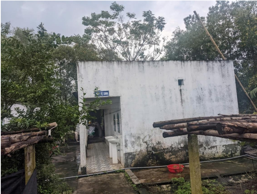
Hình 3.4 Nhà vệ sinh của nhà máy phân bón Sông Gianh
