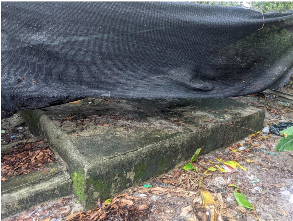
Hình 3.5 Bể lắng lọc 2 ngăn xử lý NTSH của nhà máy phân bón Sông Gianh
