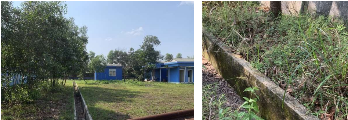
Hình 3.1. Một số hệ thống mương thoát nước khu vực cơ sở
